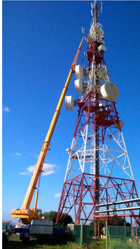
Figura. Mantenimiento de un radiante de un radioenlace situado en la torre de telecomunicaciones que entre sus funciones cumple la de estación repetidora.
